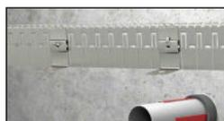
Sistemare l'aggancio di fissaggio e piegare la bandella nella posizione originaria. Distribuire ad equal distanza gli agganci di fissaggio
