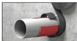
Assicurarsi che lo spazio attorno al tubo sia sigillato al fuoco e al fumo con CORH FM I Malta o equivalente. Avvolgere la benda intumescente attorno al tubo (premontare il numero di strati richiesti\*) Lasciare un eccesso di banda di 20 mm
